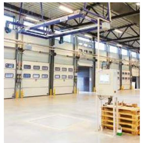
Deckenmodul Volumen, Bodenwaage eingebaut, Bedieneinheit
